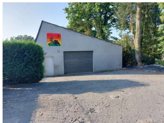
Réhabilitation de l'ancien local des services techniques
